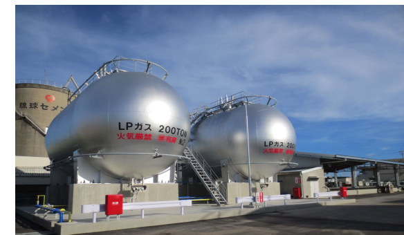
LPガス充填所
